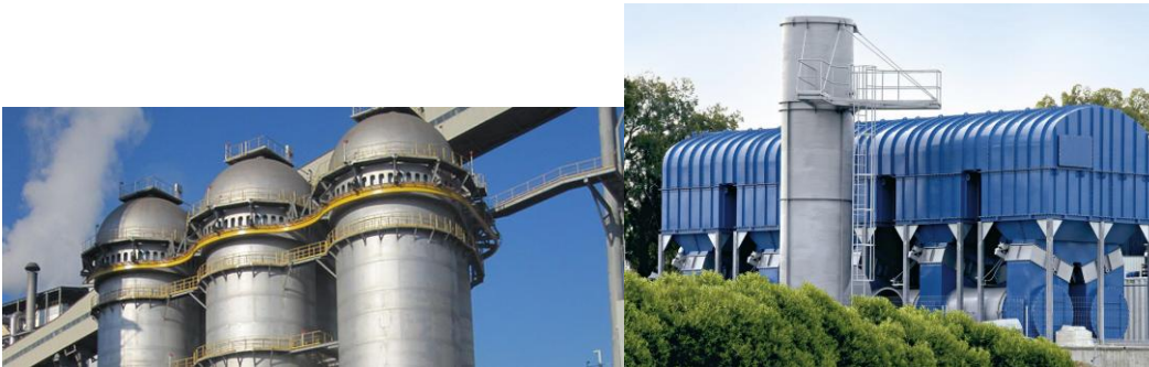
Abb. 1: Winderhitzer im Hochofenprozess (links), Thermisch-oxidative Abluftreinigung (rechts). Quelle: [1](links), [7](rechts)
